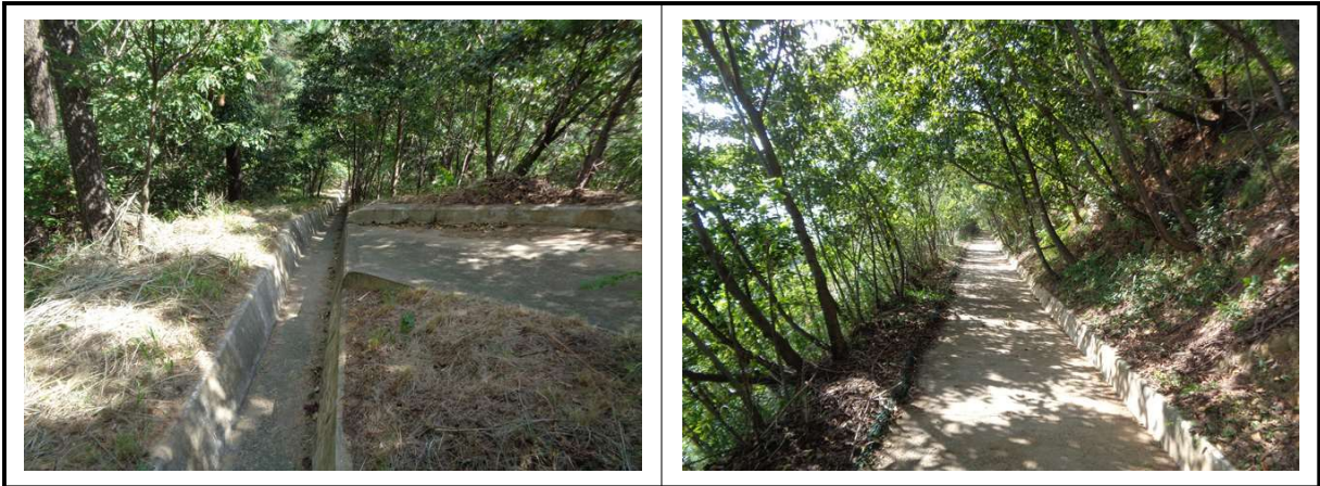
【그림 4.3.3】 배수시설 전경
